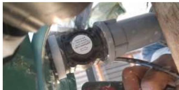
Gambar 7. Pemasangan Sensor Q 1
