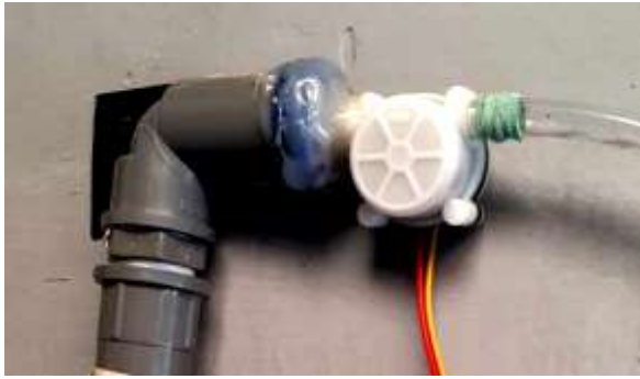
Gambar 8. Pemasangan Sensor Q 2
